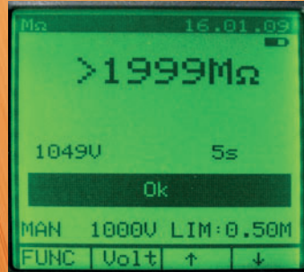
Isolationsmessung mit 1000 V DC
